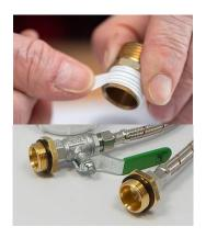
Die 3/8 Gewinde der mitgelieferten Anschluss-Schläuche mit Dichtmittel (Teflonband) abdichten und in das Filtergehäuse schrauben
